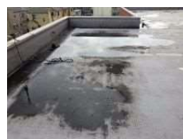
屋上防水の滞水、防水層膨れ
