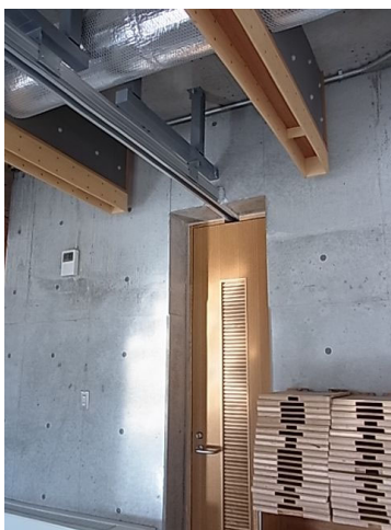
多目的スペースの可動レール
