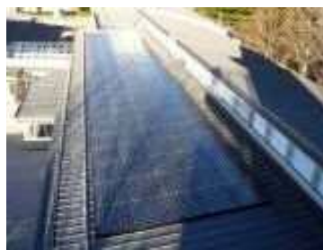
体育館屋根面のプール
