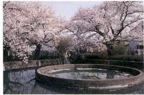
二ヶ領用水久地内筒分水
