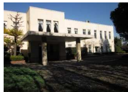
登録有形文化財 昭和電工川崎事業所本事務所
