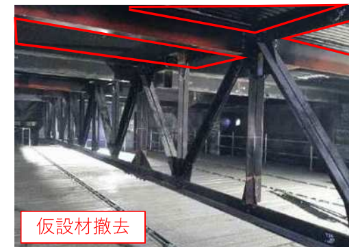
【仮設材撤去状況】
