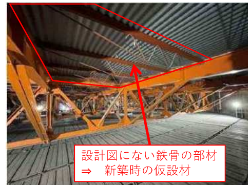
【②－3：大ホール屋根鉄骨梁の違い】
