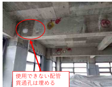
【設計図と異なる配管貫通孔の数】
