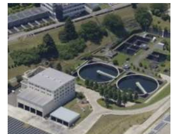
長沢浄水場排水処理施設
