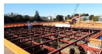
脱窒ろ過池工事
