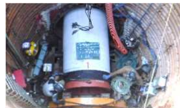
雨水管布設（推進工法）
