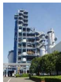
使用済プラスチックから水素等を製造するプラント (レゾナック川崎事業所)
