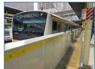
ホームドア設置例 (JR 南武線武蔵小杉駅)
