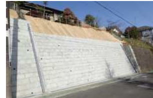
助成制度を活用した 擁壁の改修例
