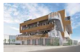
宮前区保育・子育て総合支援センター(令和5年度開設)
