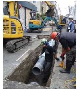
耐震管布設工事
