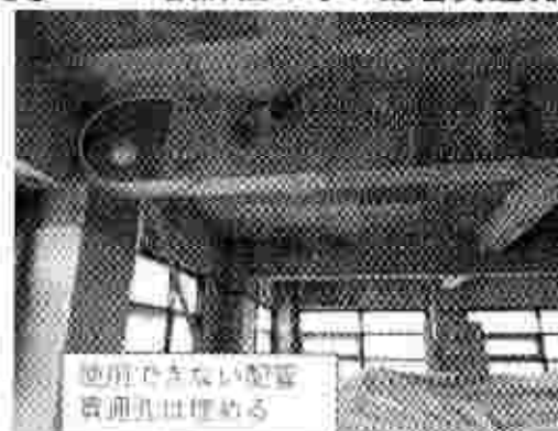
【設計図と異なる配管貫通孔の数】
