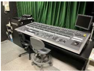
① 工事 舞台照明調整
