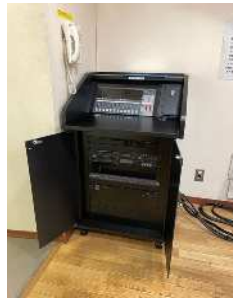
① 工事 舞台音響調整 卓2式(大会議室、視聴)
