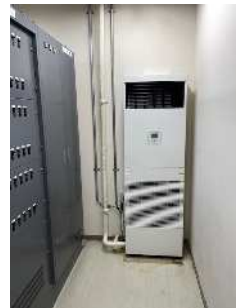
② 工事 パッケージエアコン
