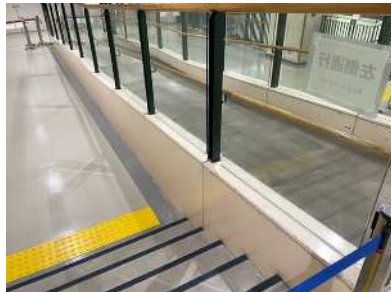
④12階手摺・点状ブロック
