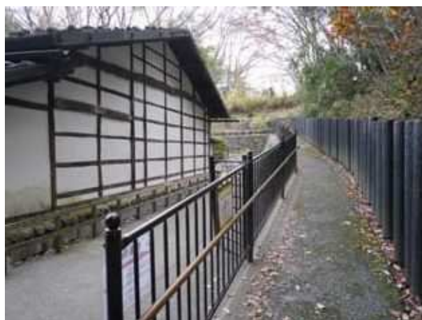
増設した車椅子用スロープ
