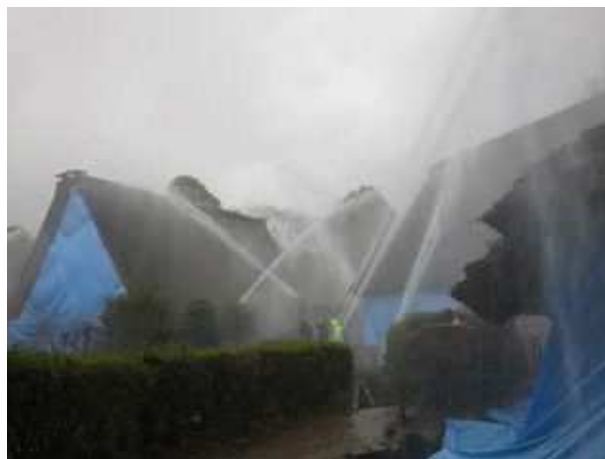
消火設備の放水試験
