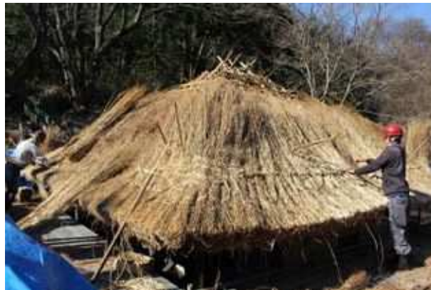
茅葺屋根の葺替え
