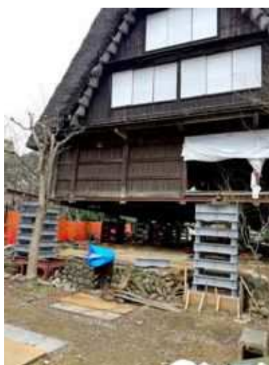
耐震補強工事
