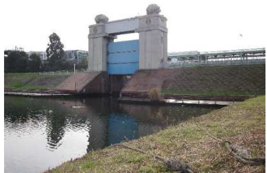
川崎河港水門
