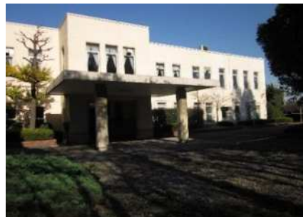
国登録有形文化財 昭和電工川崎工場本事務所
