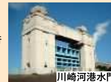
川崎河港水門
