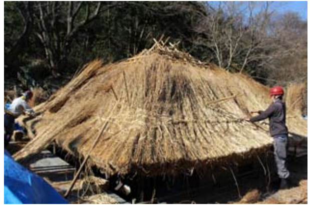
茅葺屋根の葺替え
