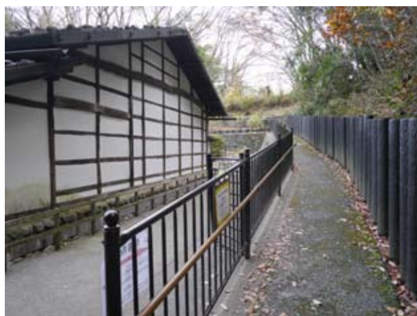
増設した車椅子用スロープ
