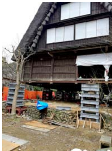
耐震補強工事
