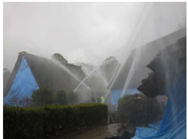
消火設備の放水試験
