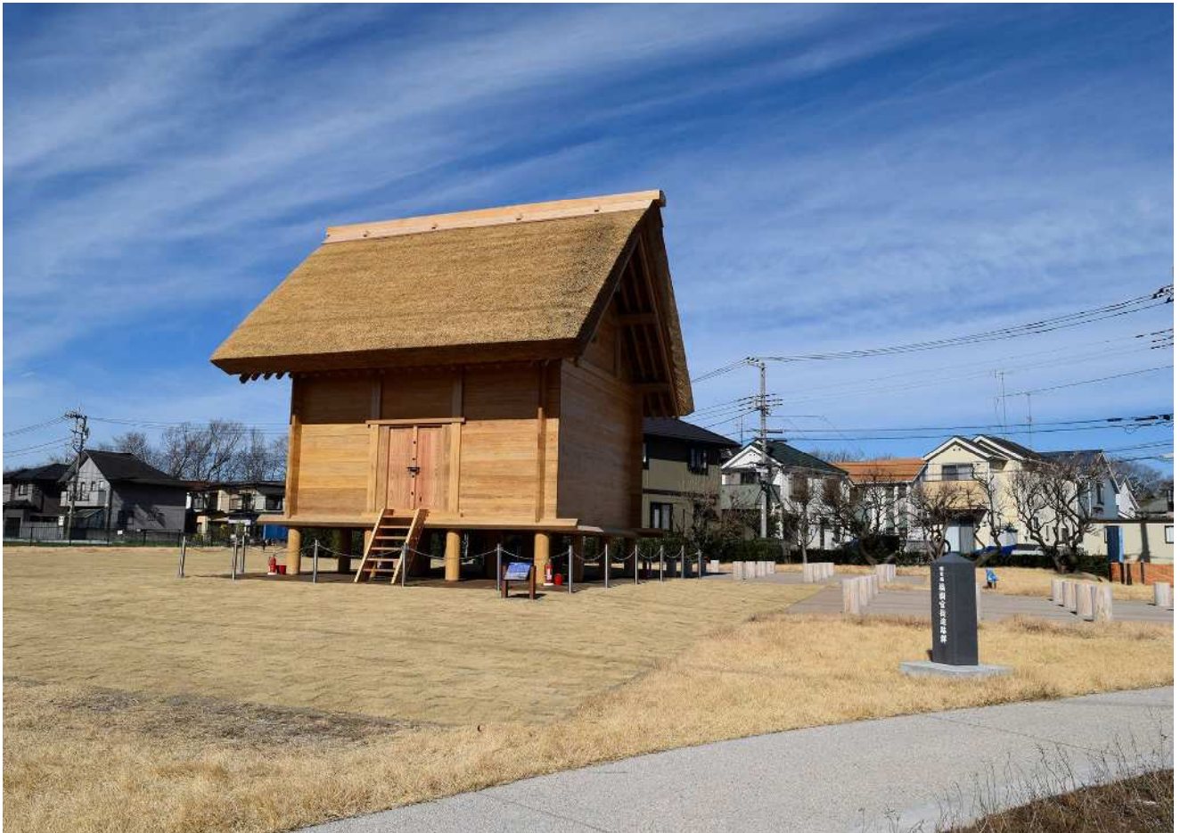
写真 2 飛鳥時代の復元倉庫と史跡標柱（南東から）
