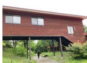
鳥の棟渡り廊下
