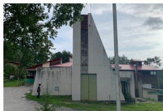
躯体の劣化が著しいエネルギー棟
