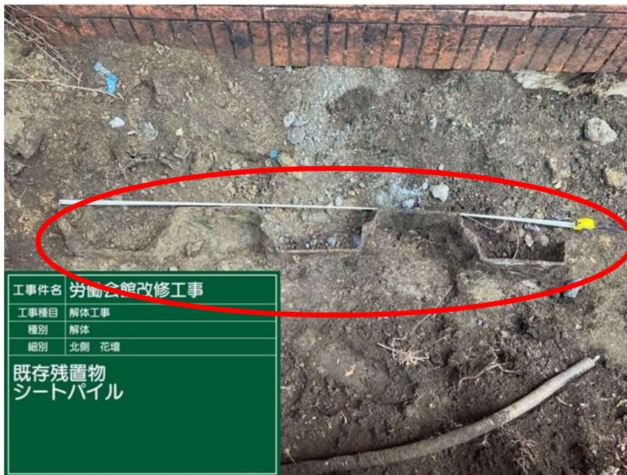
【埋設シートパイル】
