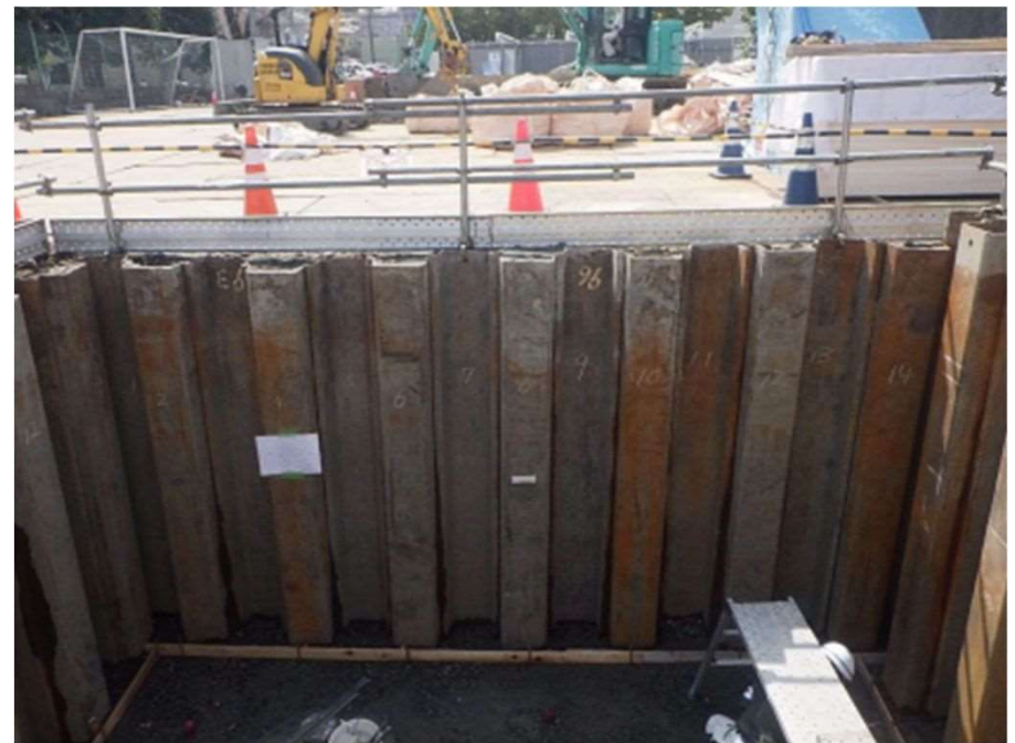
【他工事での事例】
