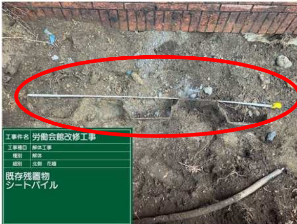
【埋設シートパイル】
