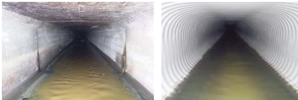
管きょの耐震化(左:耐震化前、右:耐震化後)
