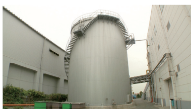
バイオマス発電施設
