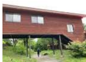
鳥の棟渡り廊下
