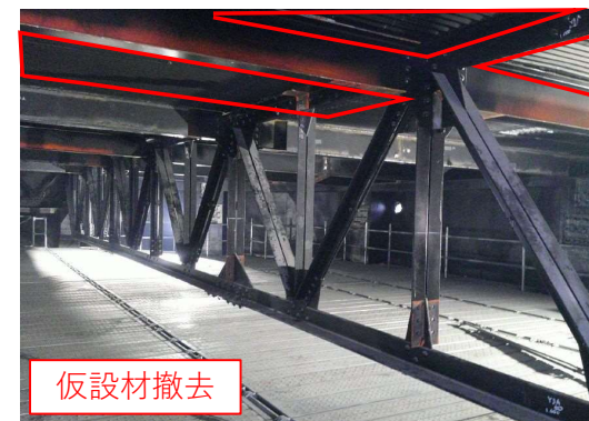
【仮設材撤去状況】
