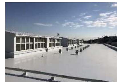
屋上防水改修
