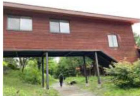
鳥の棟渡り廊下
