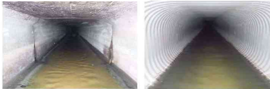
管きよの耐震化 (左:耐震化前、右:耐震化後)
