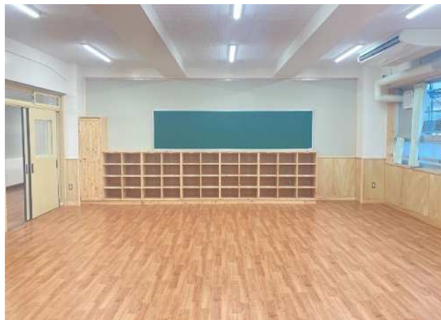
内装改修 (普通教室)
