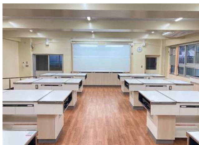
内装改修 (特別教室)
