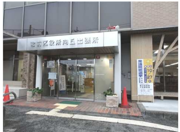
【支所・出張所等への看板掲出（向丘出張所）】
