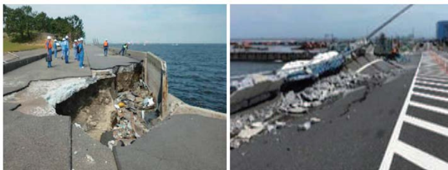
横浜港金沢地区の護岸被災 （令和元年台風第15号）
