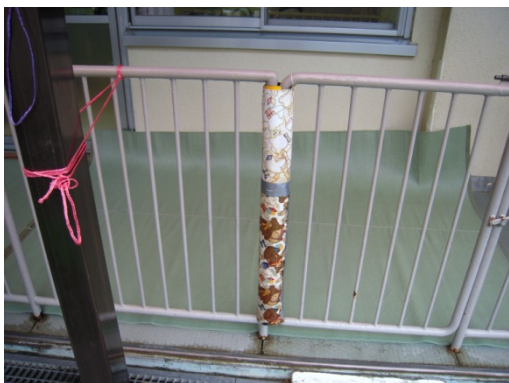
(写真) 中野島保育園内通路にあった腐食した鉄柵
