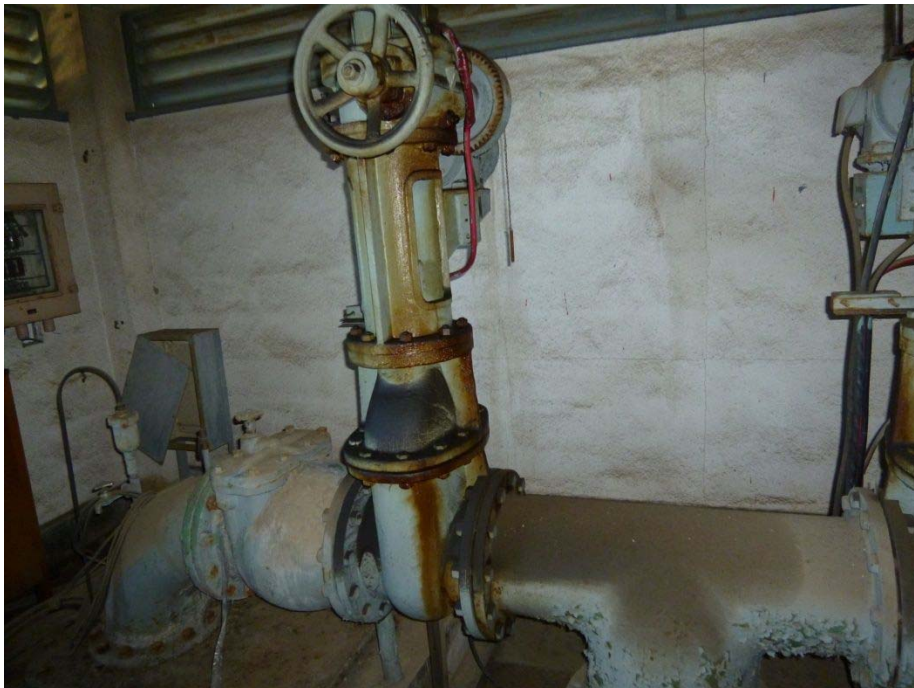
【菅7号さく井（内部）】
