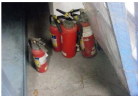
古い消火器①
