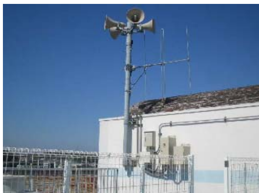
トランペット型スピーカー：麻生区麻生中学校
