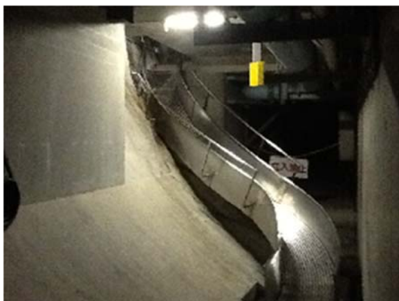
写真 20 トンネル側壁からの脱出口（9 月 17 日監査人撮影）
