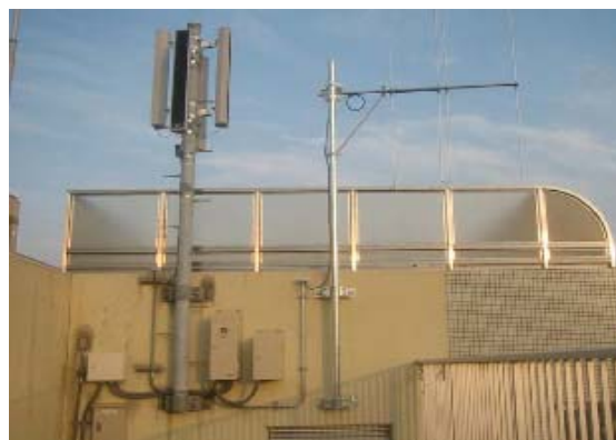
防災用スリムスピーカー：多摩区菅小学校
