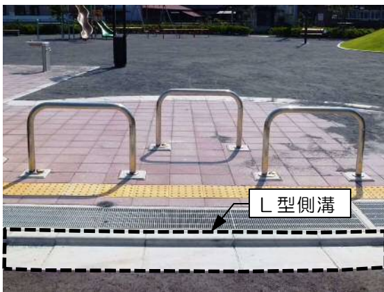
公園出入口とL型側溝（参考写真）
