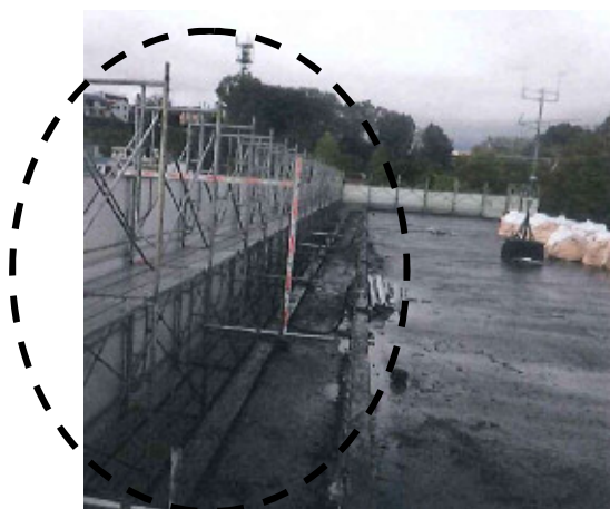
作業床（参考写真）
