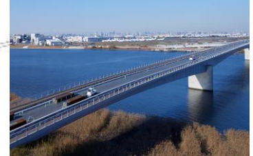
「多摩川スカイブリッジ」 (令和4年3月12日開通)
