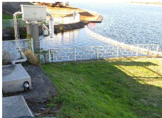
「ピクニック橋整備前の写真」
