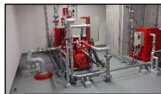
【消火ポンプ室】
