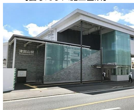
【曇りガラス施工箇所】
