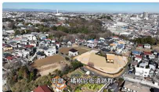
橘樹官衙遺跡群 復元建物工事
