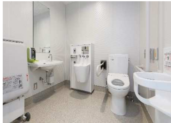
▲誰でもトイレ～ユニバーサルシート設置～
