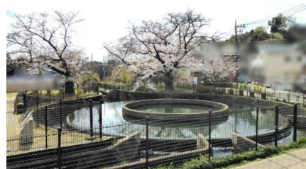
【久地円筒分水】
