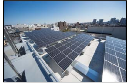
【屋上に設置された太陽光パネル】
