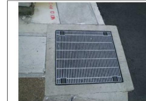
白杖(盲人安全杖)の先端や車いすの車輪、ハイヒール等が隙間に落ち込まないように配慮した網目の細かいグレーチング(側溝等のふた)
