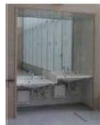
車椅子でも利用し易く 体格差にも配慮した 下部開放、高さ2種の手洗
