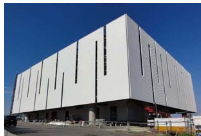
工事現況写真（9月撮影）
