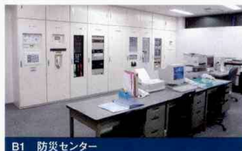
B1 防災センター
