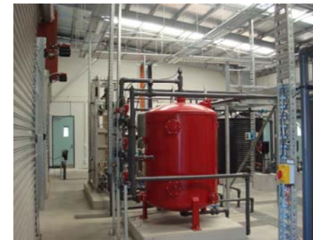
活性炭注入設備
