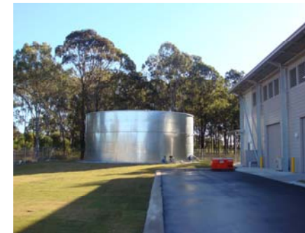
屋根雨水の貯留タンク(中央)と浄水処理施設(右)
