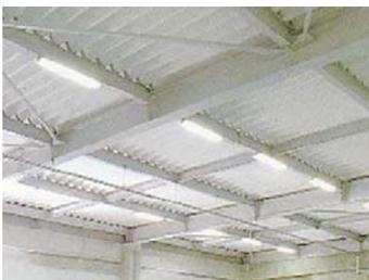
屋根用折板石綿断熱材
