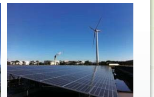
<川崎太陽光発電所> <川崎風力発電所> 稼働開始：平成23年12月 平成22年3月 最大出力：約13,000kW 最大出力：1,990kW
