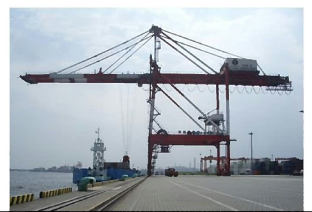
既設ガントリークレーン
