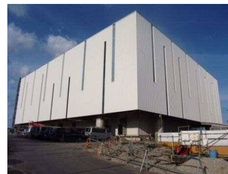
【川崎生命科学・環境研究センターLiSE(ライズ) 外観】
